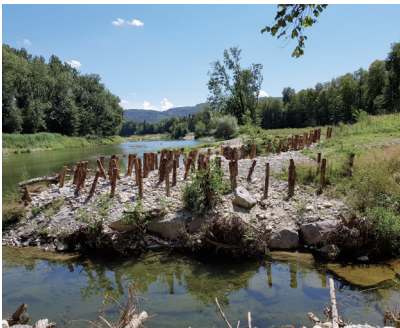
Mündungsbereich Stegbach mit frisch eingerammten Weidenstecklingen
